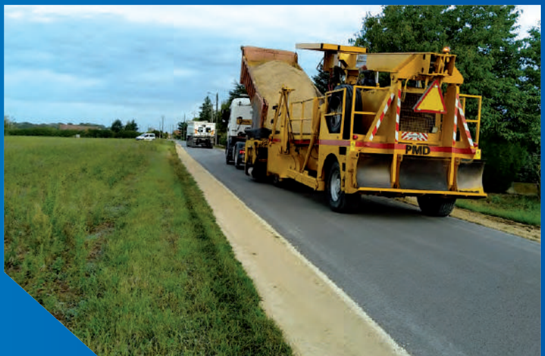
Travaux rue Verte : renforcement des accotements
