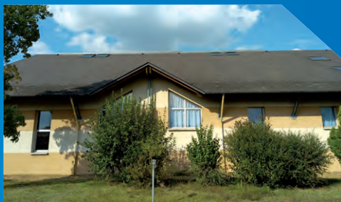
Systeme de désenfumage du gymnase
