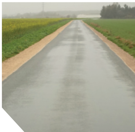
Réfection des accotements de la rue Verte (réalisation CC ValSol)
